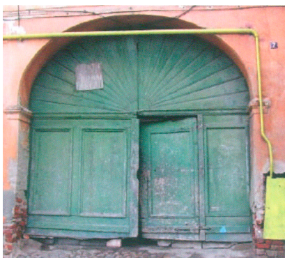
Conductele strică imaginea fațadei și sunt montate într-o zonă periculoasă
